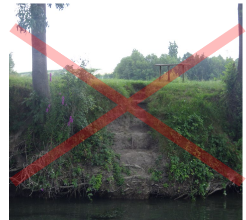
INTERDIT : Escaliers en berge
