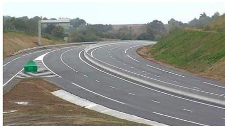
**La deuxième est relative à l'avant-projet d'aménagement du contournement routier de Mirambeau.** Cette liaison neuve à deux voies, d'une longueur de 3,5 km, comportera notamment 3 nouveaux carrefours giratoires au niveau des voies principales (RD 137 au nord et au sud, RD 730 à l'est) ainsi qu'un ouvrage permettant de passer en-dessous de la RD 730. Le coût total (travaux plus études et acquisitions foncières) s'élève à 11,8M€.
