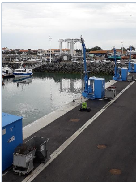
Figure 4. Bennes métalliques à proximité des grues
